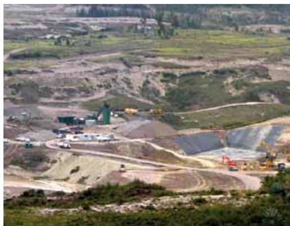
Rehabilitación del antiguo botadero de Zábiza en Quito
