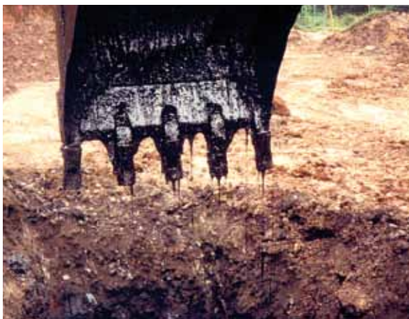
Remediación de contaminación por aceite de alquitrán en Stuttgart
