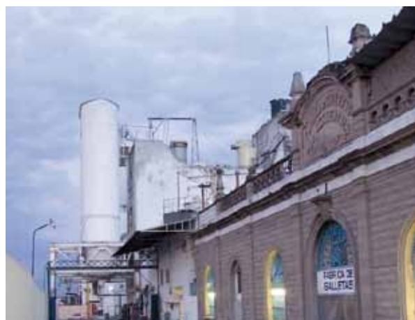
Antigua planta industrial en Guadalajara
