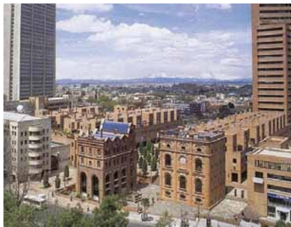
Los edificios históricos de la cervecería Bavaria en Bogotá se reutilizaron como instalaciones comerciales y de ocio después de la renovación urbana
